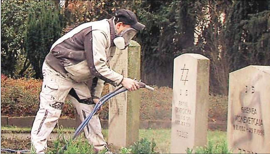
Reinigungsarbeiten: Vorsichtig entfernten Mitarbeiter der Firma Janßen & Sohn die Hakenkreuze auf den Grabsteinen.
